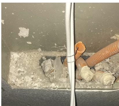
Figura 5 – Material isolante da instalação de ar condicionado estrangulada
