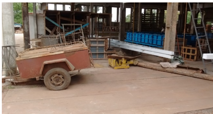
Figura 3 – Limpeza da área ao lado da Metalúrgica
