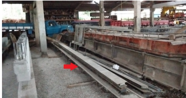
Figura 9 – Empilhamento incorreto das pranchas das formas
