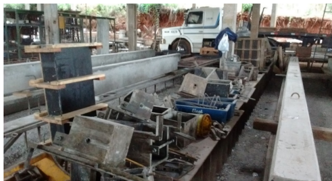
Figura 7 – Acúmulo de materiais sobre a forma de pilar
