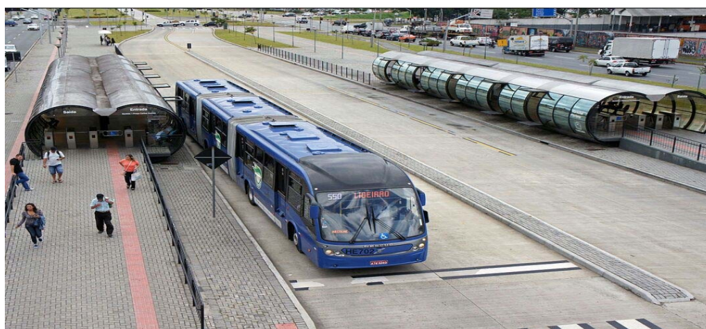
Figura 2 - Parada tubular de ônibus da Estação Marechal Floriano
